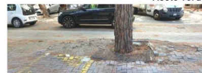
Pavimentazioni ammalorate
